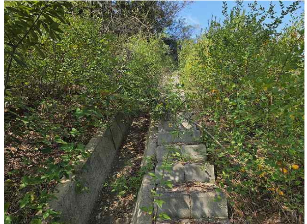
산마루측구, 점검계단 전경
