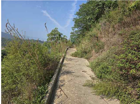
1소단 배수로 전경
