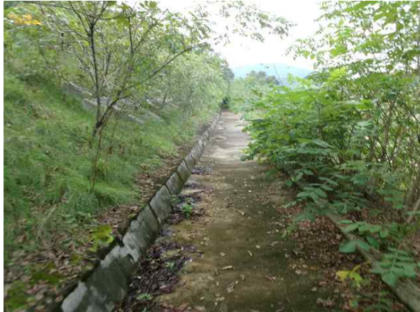
1소단 배수로 전경
