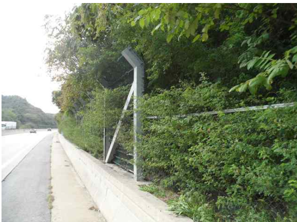
하부, 낙석방지울타리 전경
