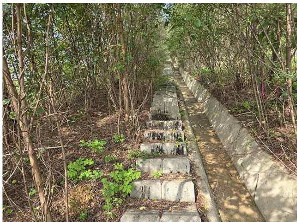
산마루측구, 점검계단 전경
