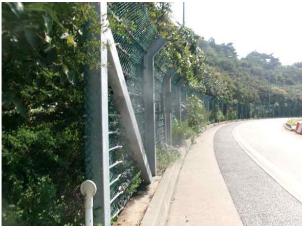
도로, 낙석방지울타리 전경
