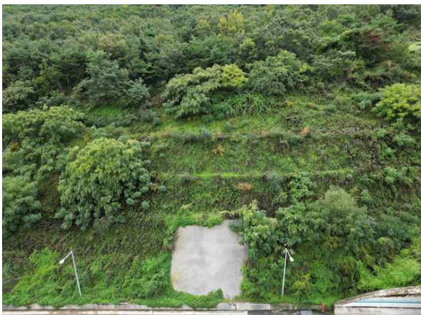
숏크리트 보호공 전경
