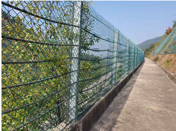
1소단배수로 낙석방지울타리 전경
