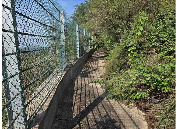
2소단 배수로 전경
