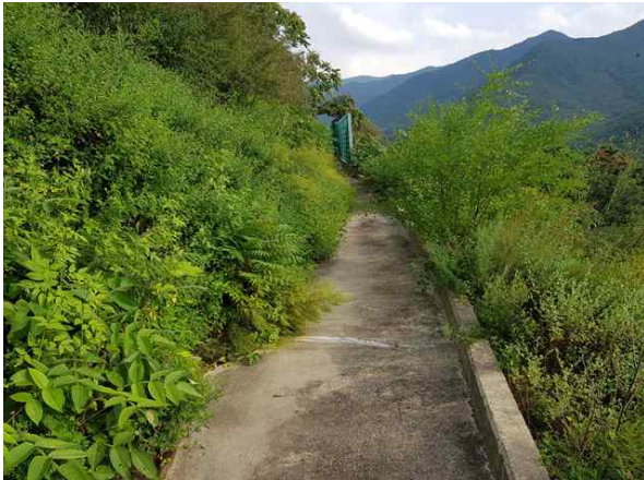
소단배수로, 낙석방지울타리 전경
