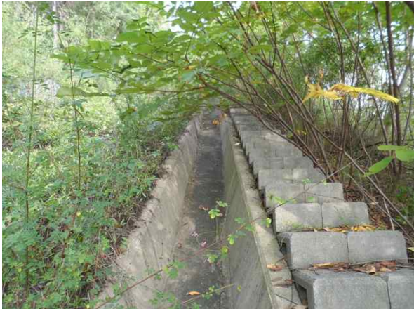
산마루측구, 점검계단 전경
