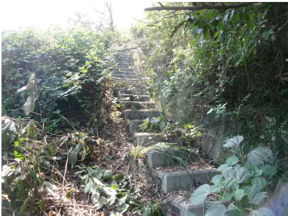
점검계단, 산마루측구 전경
