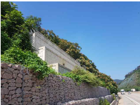
옹벽, 개비온 전경
