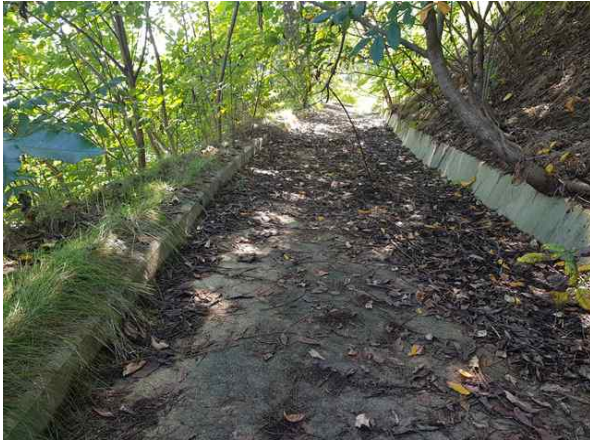
1소단 배수로 전경
