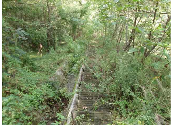
산마루측구, 점검계단 전경
