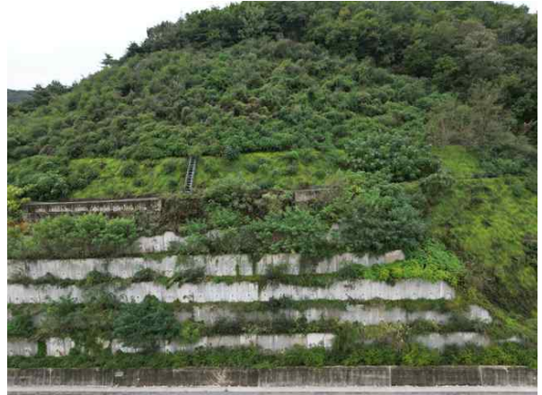
사면내 옹벽 전경
