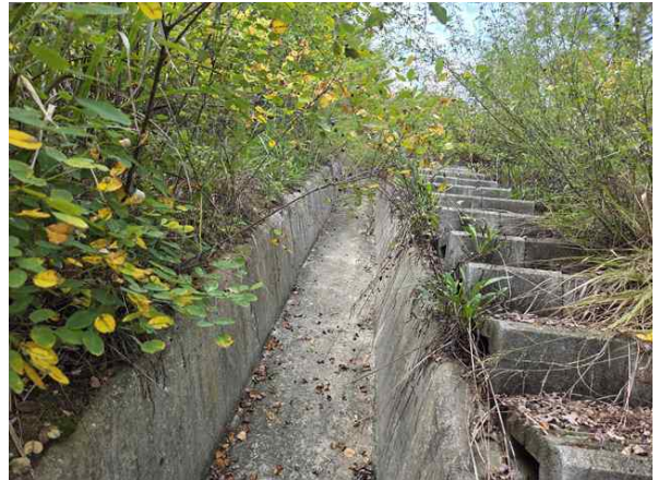
산마루측구, 점검계단 전경
