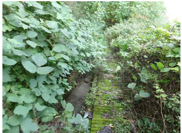
산마루측구, 점검계단 전경
