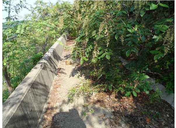
1소단 배수로 전경
