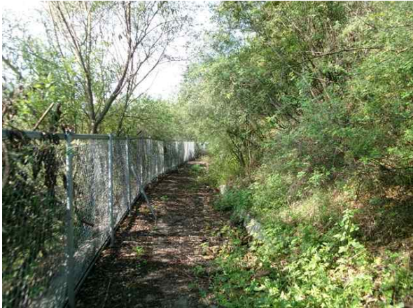
1소단 배수로 전경
