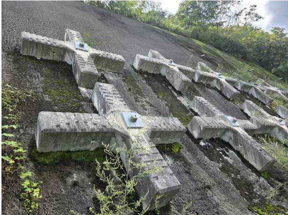
숏크리트, 격자앵커 전경
