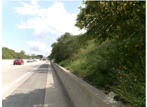
도로, 하부 전경
