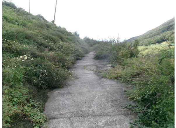
1소단 배수로 전경
