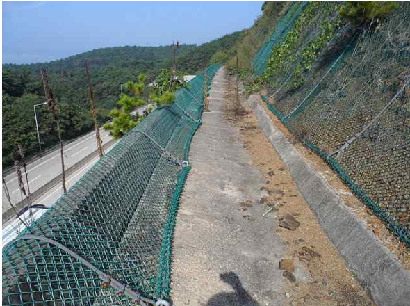
2소단 배수로 전경
