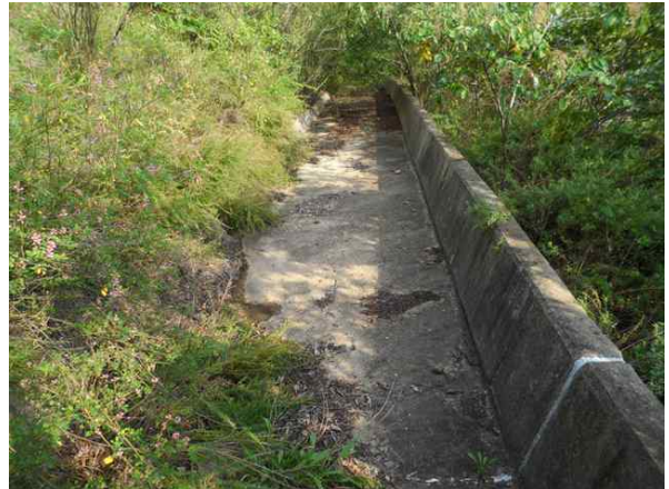
1소단 배수로 전경
