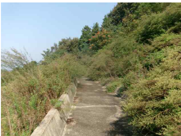
1소단 배수로 전경
