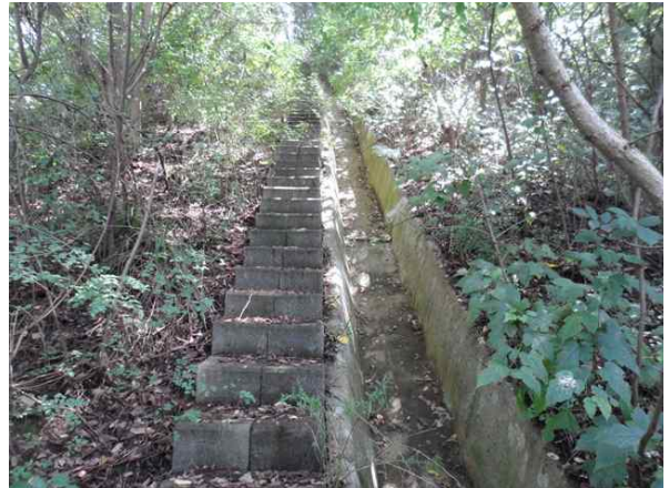
산마루측구, 점검계단 전경
