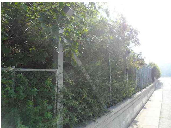
도로, 낙석방지울타리 전경
