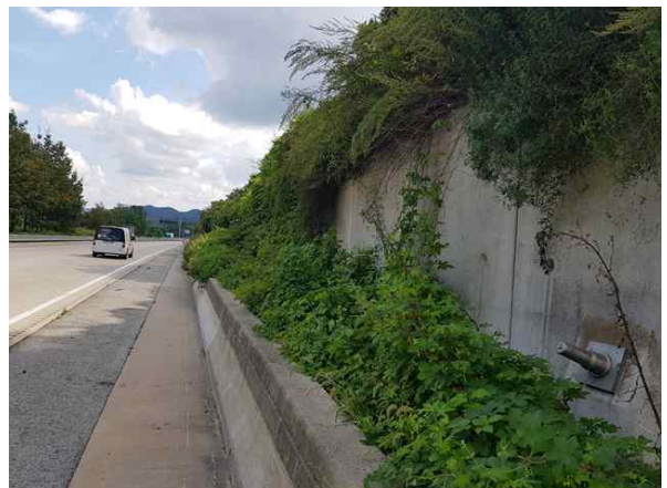
사면부, 하단 판넬형옹벽 전경
