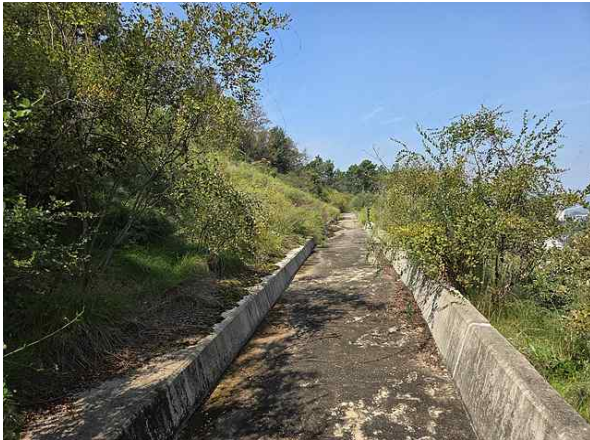
1소단 배수로 전경
