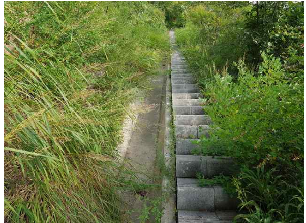
산마루측구, 점검계단 전경
