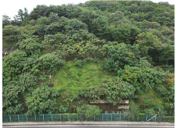
사면내 옹벽 전경
