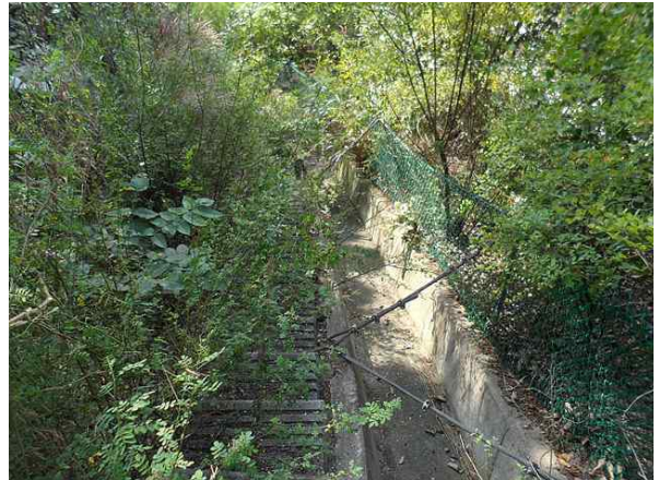
점검계단, 산마루측구 전경
