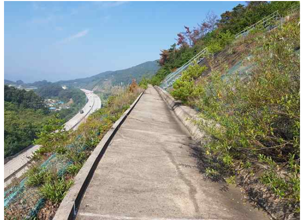
2소단 배수로 전경
