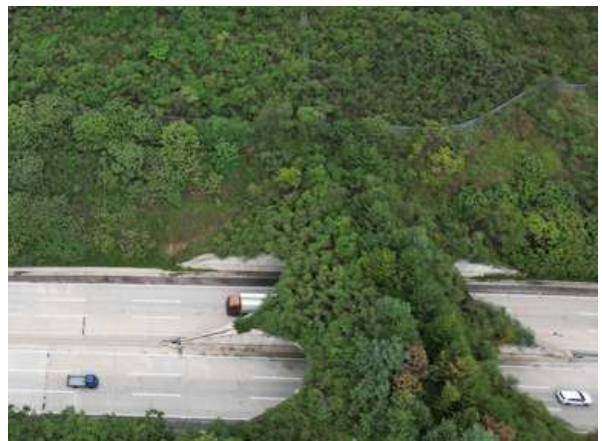
상태육교 상부 전경
