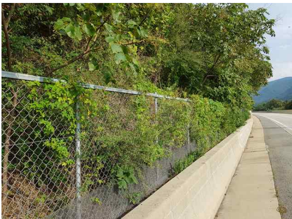
하단 도로부 전경
