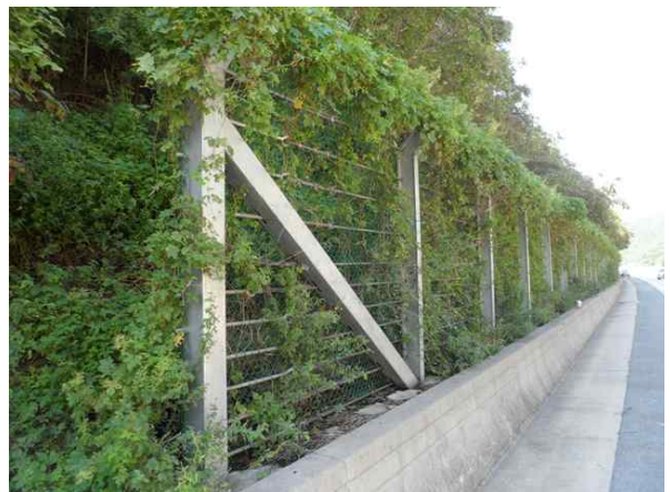
도로, 낙석방지울타리 전경
